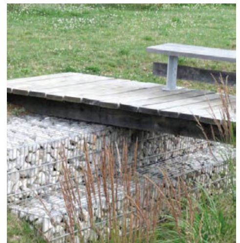
Exemple de saut de loup avec passerelle
