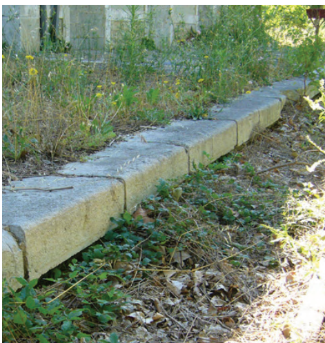
Bordures des quais de la gare Lorient-Aubignan
