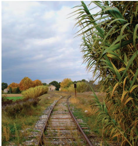
Cannes de Provence sur talus ferroviaire
