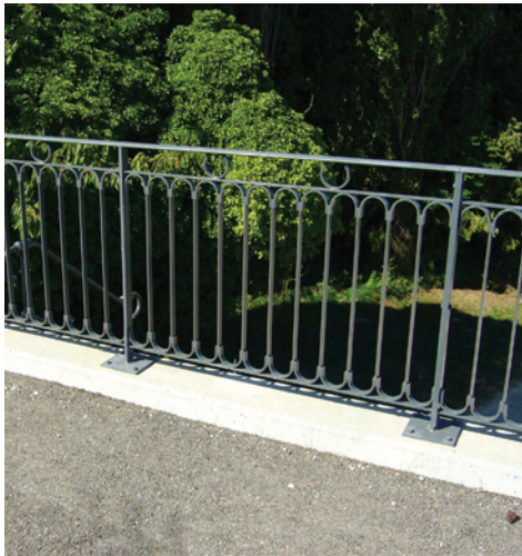
Garde-corps d'un ouvrage de franchissement de la Via venaissia
